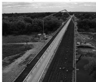
Rys. 10. Wzmocnienie mostu drogowego przez rzekę Bug w miejscowości Frankopol; zilustrowano skomplikowany proces wzmocnienia konstrukcji zespolonej z kratownicami stalowymi o schemacie statycznym belki ciągłej
