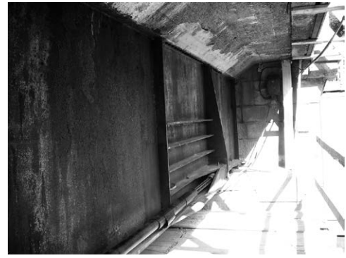
Rys. 4. Uźbierowanie w strefie zakotwienia kabla i śruby w pasie górnym jako wzmocnienie połączenia ścinanego zespolonego mostu w Kłodzku
