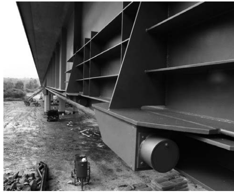
Rys. 8. Most w Zakliczynie po sprężeniu dźwigara skrajnego
