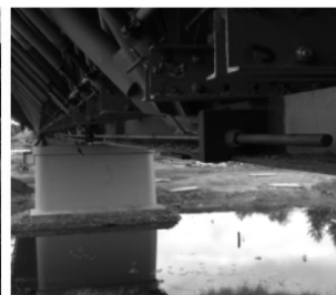
Rys. 10. Wzmocnienie mostu drogowego przez rzekę Bug w miejscowości Frankopol; zilustrowano skomplikowany proces wzmocnienia konstrukcji zespolonej z kratownicami stalowymi o schemacie statycznym belki ciągłej
