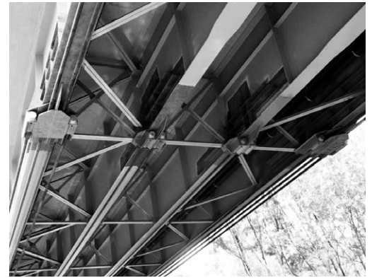
Rys. 9. Most w Zakliczynie – widok od spodu po sprężeniu
