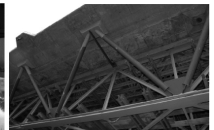
Rys. 10. Wzmocnienie mostu drogowego przez rzekę Bug w miejscowości Frankopol; zilustrowano skomplikowany proces wzmocnienia konstrukcji zespolonej z kratownicami stalowymi o schemacie statycznym belki ciągłej
