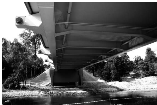
Rys. 2. Most drogowy przez rzekę Pilicę w miejscowości Maluszyn – widoczne sprężenie poprzeczne oraz rozbudowana konstrukcja pasa górnego dźwigara głównego w miejscu połączenia z poprzecznicą w strefie zamocowania wspornika lin podwieszających
