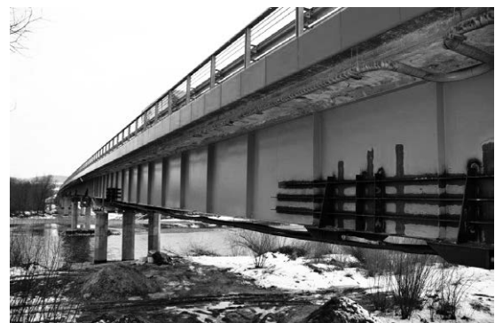
Rys. 7. Most w Zakliczynie – widok po zainstalowaniu kabli
